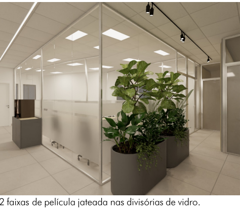
2 faixas de película jateada nas divisórias de vidro.
